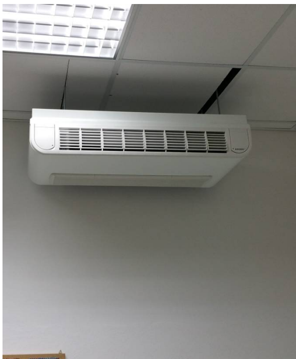
ventilconvettori
