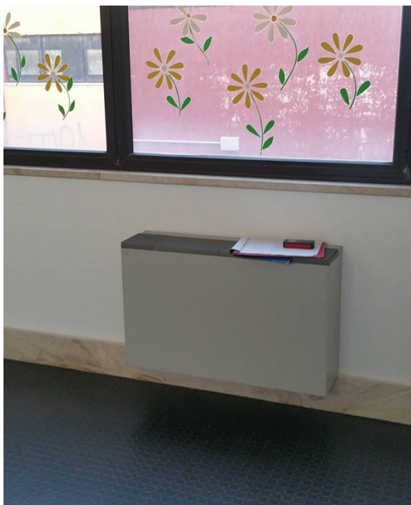
ventilconvettori
